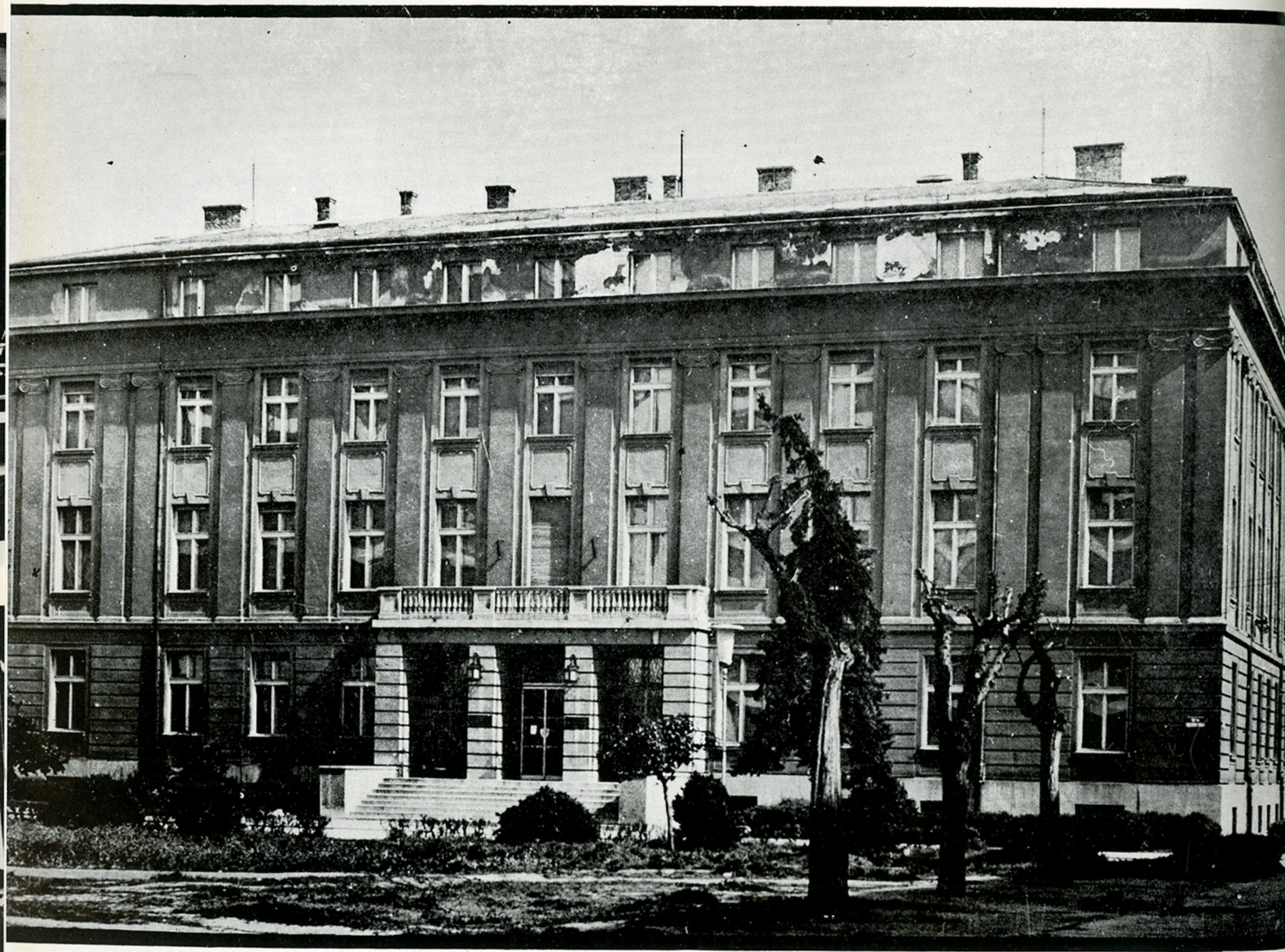
Фасад Галереи Матицы сербской в Новом Саде.
