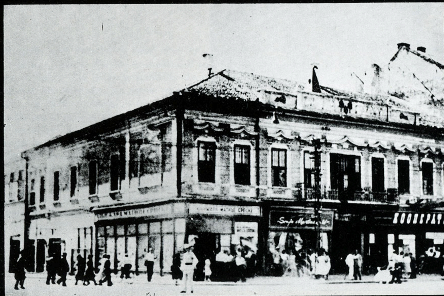
Edifice de Matica Srpska après la Seconde Guerre mondiale, à la veille de sa démolition
